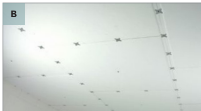
Akustiikkalevyn asennus: Kiinnitä Rockfon Mono Acoustic -levyt mekaanisesti listajärjestelmään. Suora asennus (mekaanisesti/liimalla) ilmatiiviiseen alustaan on myös mahdollinen.
