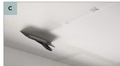
Täytä saumat, kiinnitä Rockfon Mono Acoustic Tape ja viimeistele saumat: Käytä haluamaasi työkalua sauman täyttämiseen. Toista, kunnes sauma on kunnolla tasoitettu.
