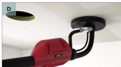
Hio saumat: Hio täytetyt saumat haluamallasi työkalulla tasataksesi akustiikkalevyn saumapinnan.
