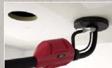
D / Saumojen hionta Hio täytetyt saumat haluamallasi työkalulla tasoittaaksesi levyn pinnan.
