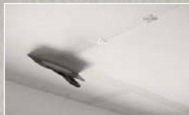
C / Saumojen täyttö, saumanauhan ja saumojen viimeistely Käytä saumojen täyttämiseen haluamaasi työkalua. Toista, kunnes sauma on kunnolla täytetty.
